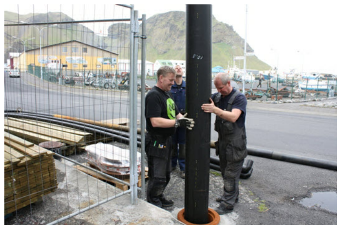
Myndir 9-10. Framkvæmdir við sjóholur norðan við viktahúsið.
