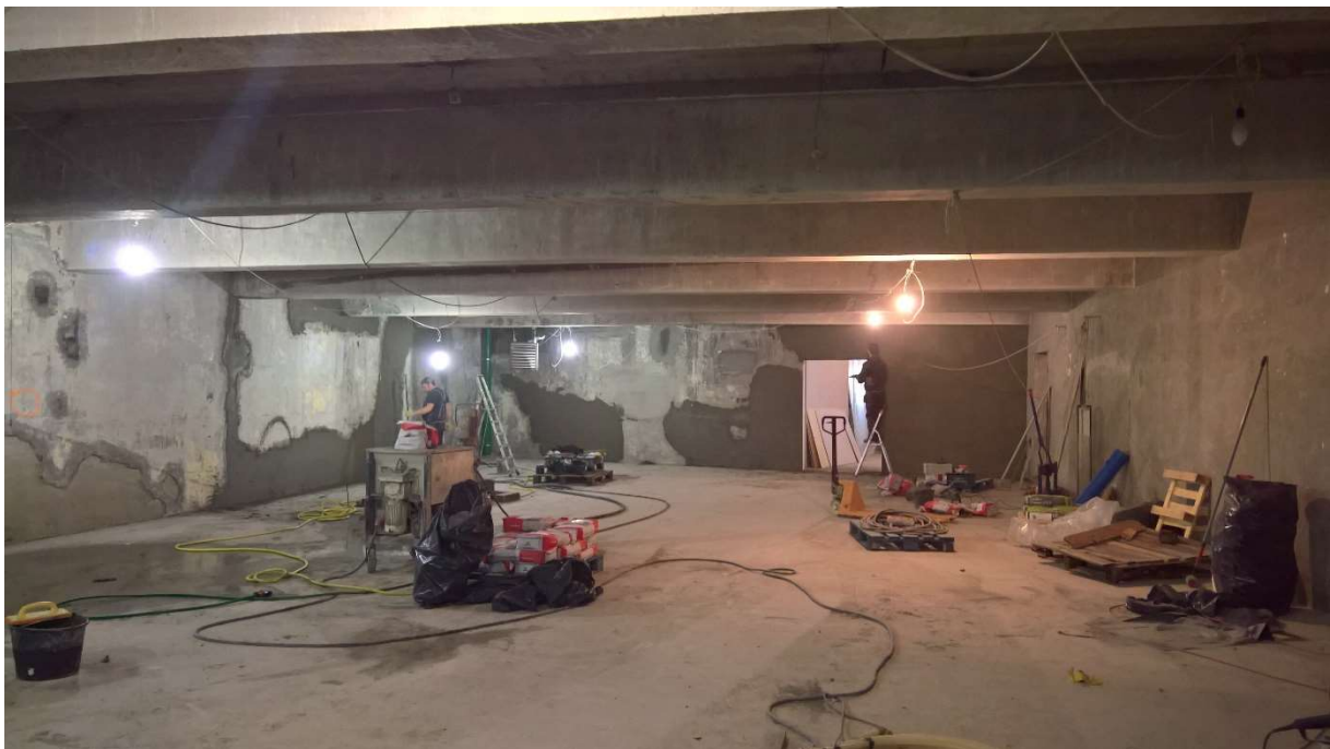
Mynd 1. Framkvæmdir í Fiskiðjunni en áætlað er að ÞSV flytji inn á 2. hæðina í lok árs 2017.
